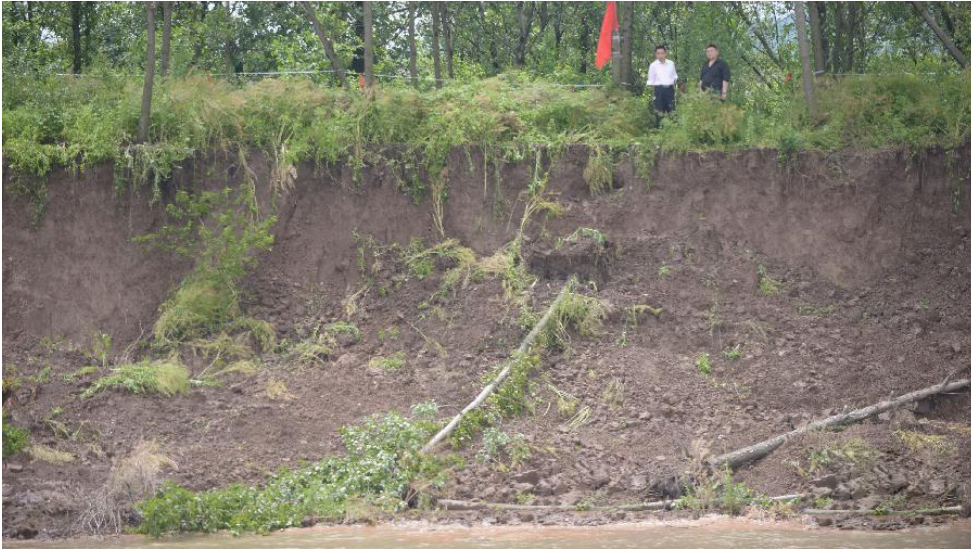
2013年5月7日，长江大堤江西彭泽段发生崩岸险情。
