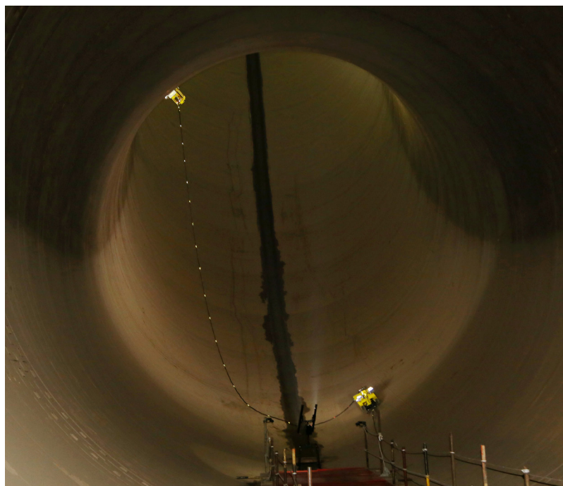
机器人开展压力钢管检查
