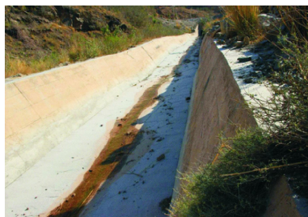
图4 泥石流沟排导槽图
