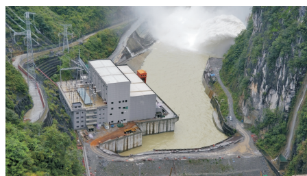
江坪河水电站工程
