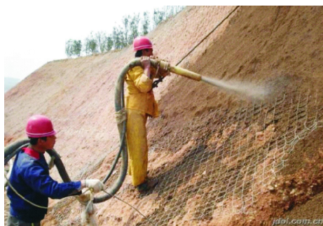
图2 边坡喷射混凝土图
