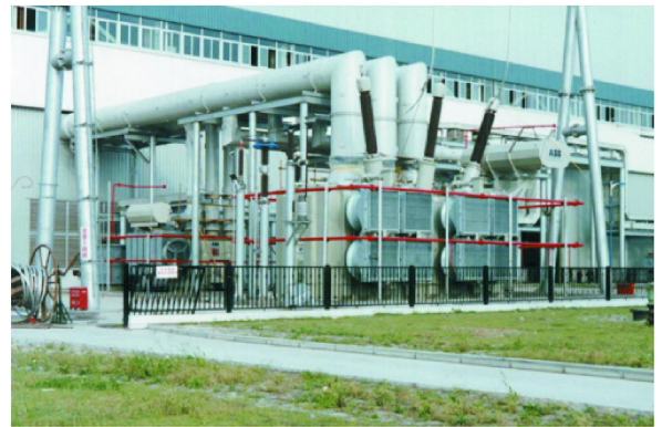
图1 IPB与主变压器连接参考图
