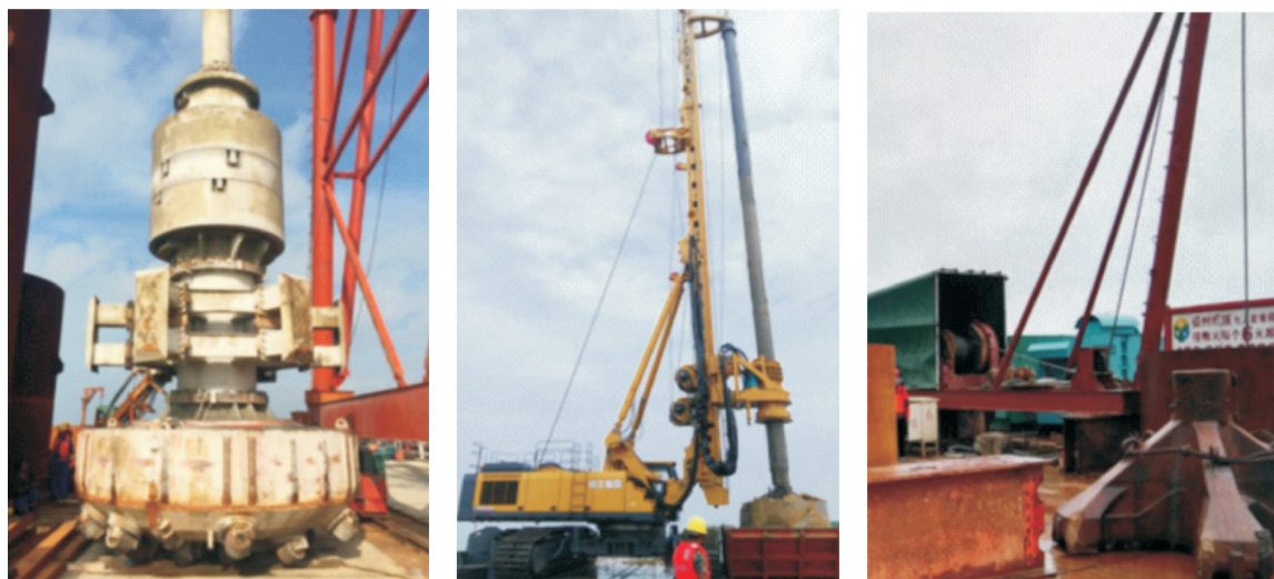
图6 常规嵌岩钻机图
