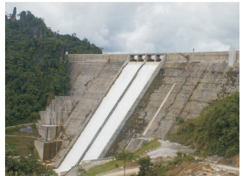
图2 沫若水电站台阶式消能泄洪照片
