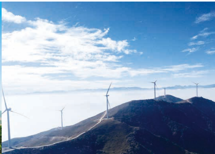
四川冕宁铁厂乡风电项目
