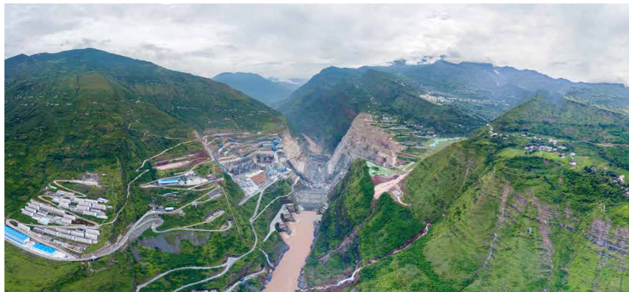
白鹤滩水电站
