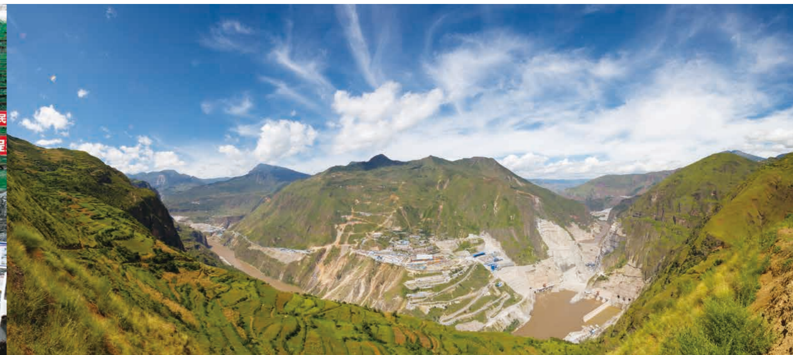
乌东德水电站
