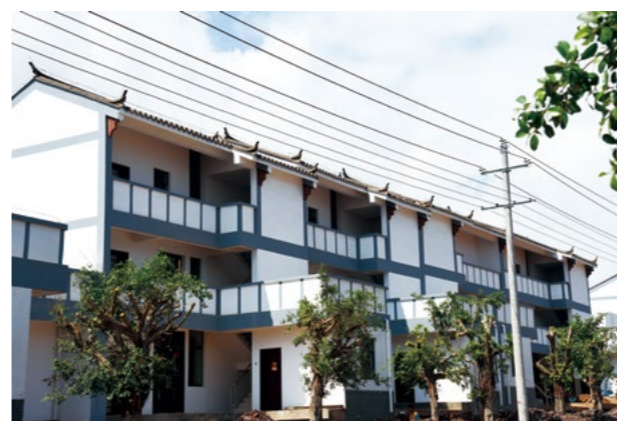
乌东德新村移民新居
