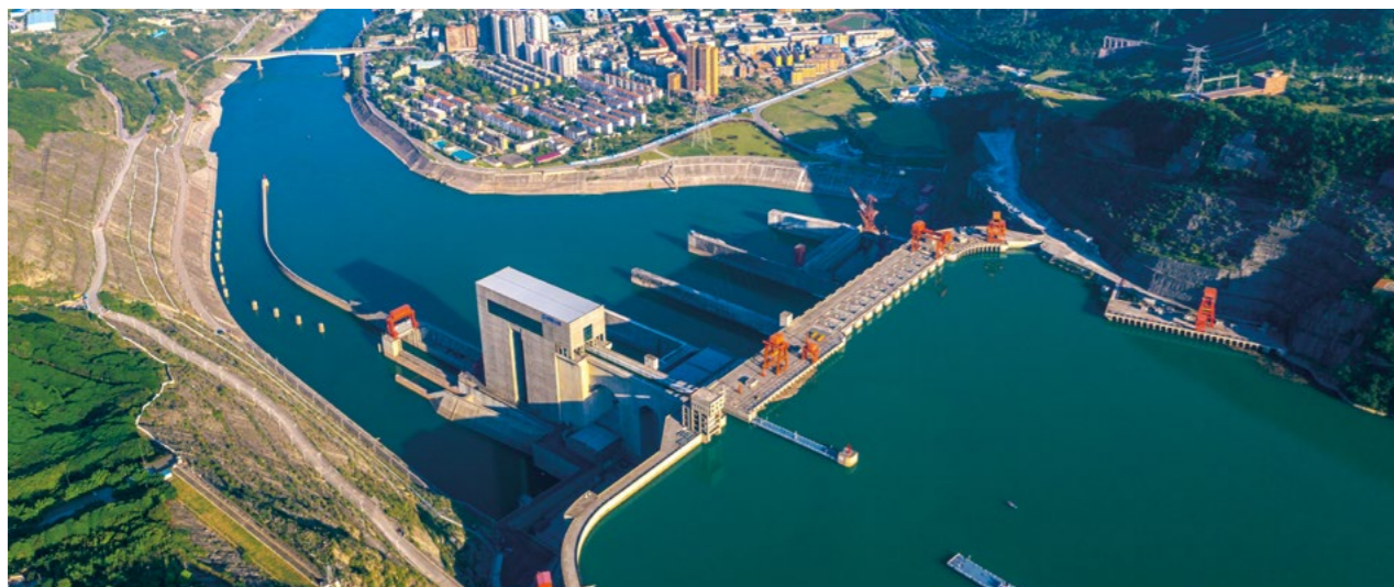
向家坝水电站
