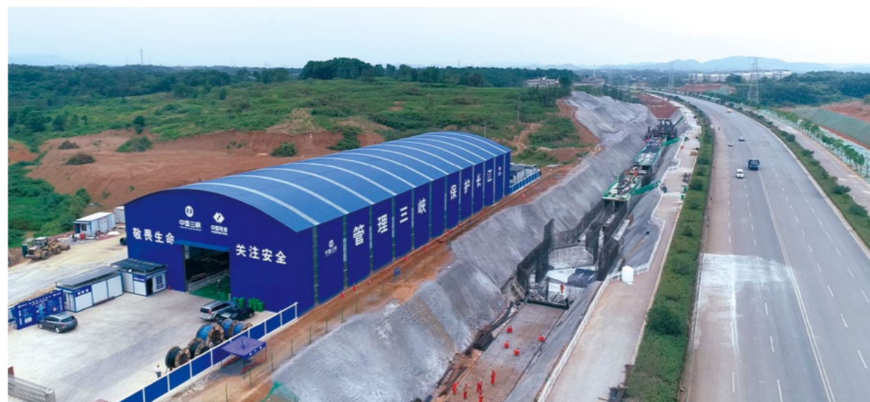
江西省九江市环赛城湖区域污染控制及生态化改造工程
