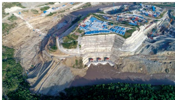
巴基斯坦卡洛特水电站项目施工现场
