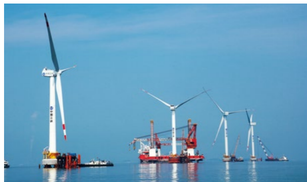
三峡福清兴化湾样机试验风场
