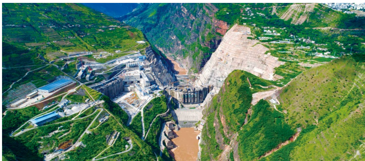
白鹤滩水电站
