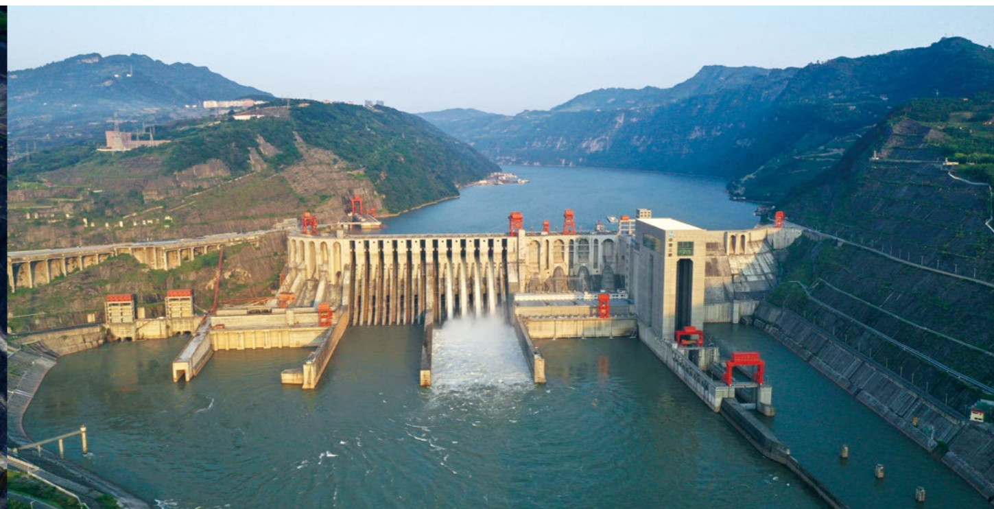
向家坝水电站
