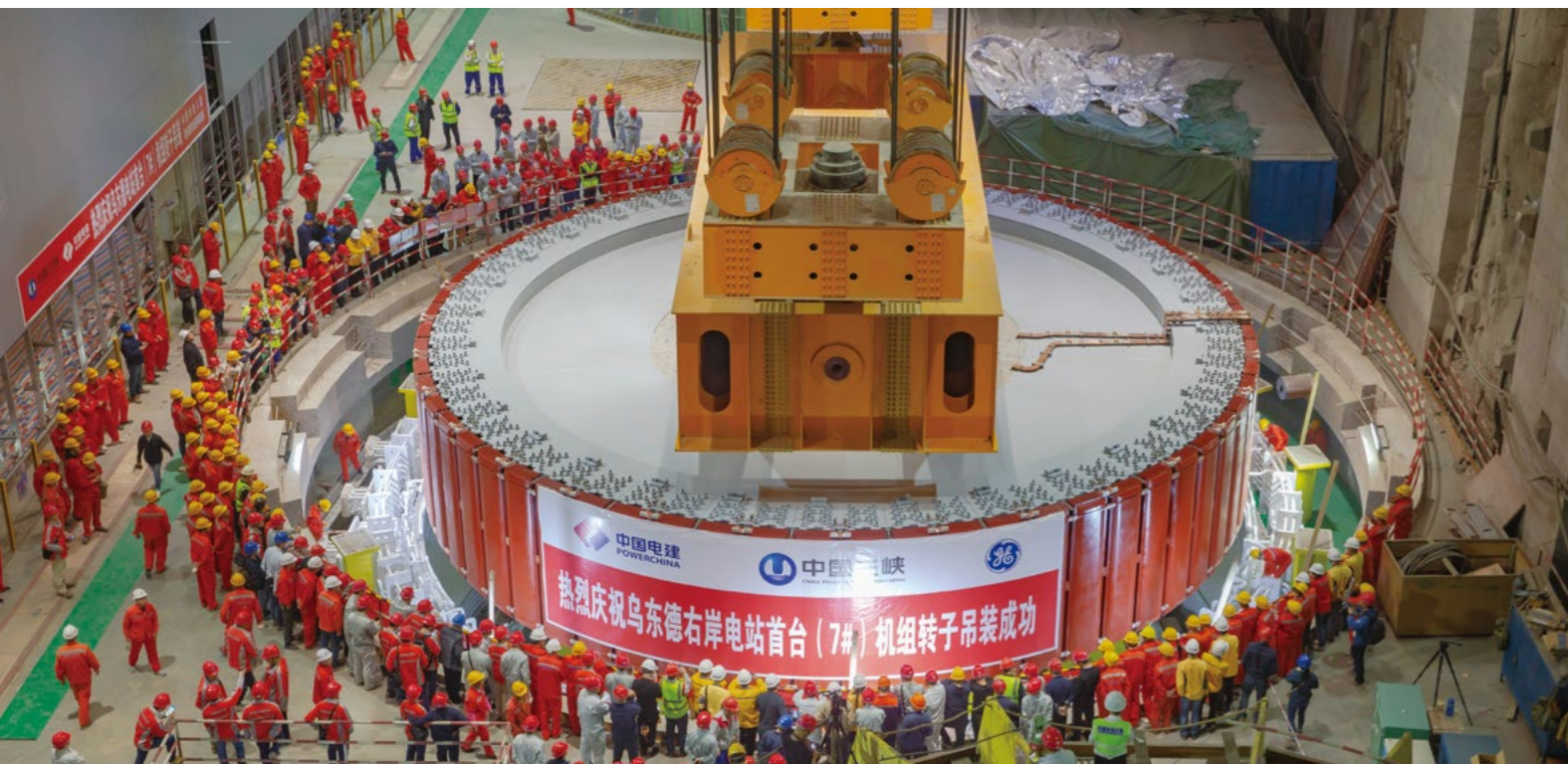
乌东德右岸电站首台 7 号机组转子吊装
