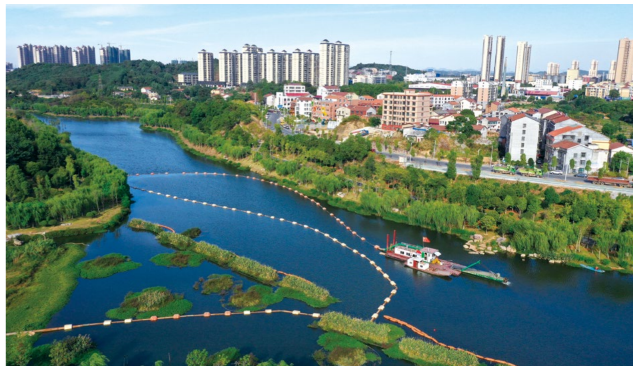
湖南省岳阳市王家河水环境综合治理工程
