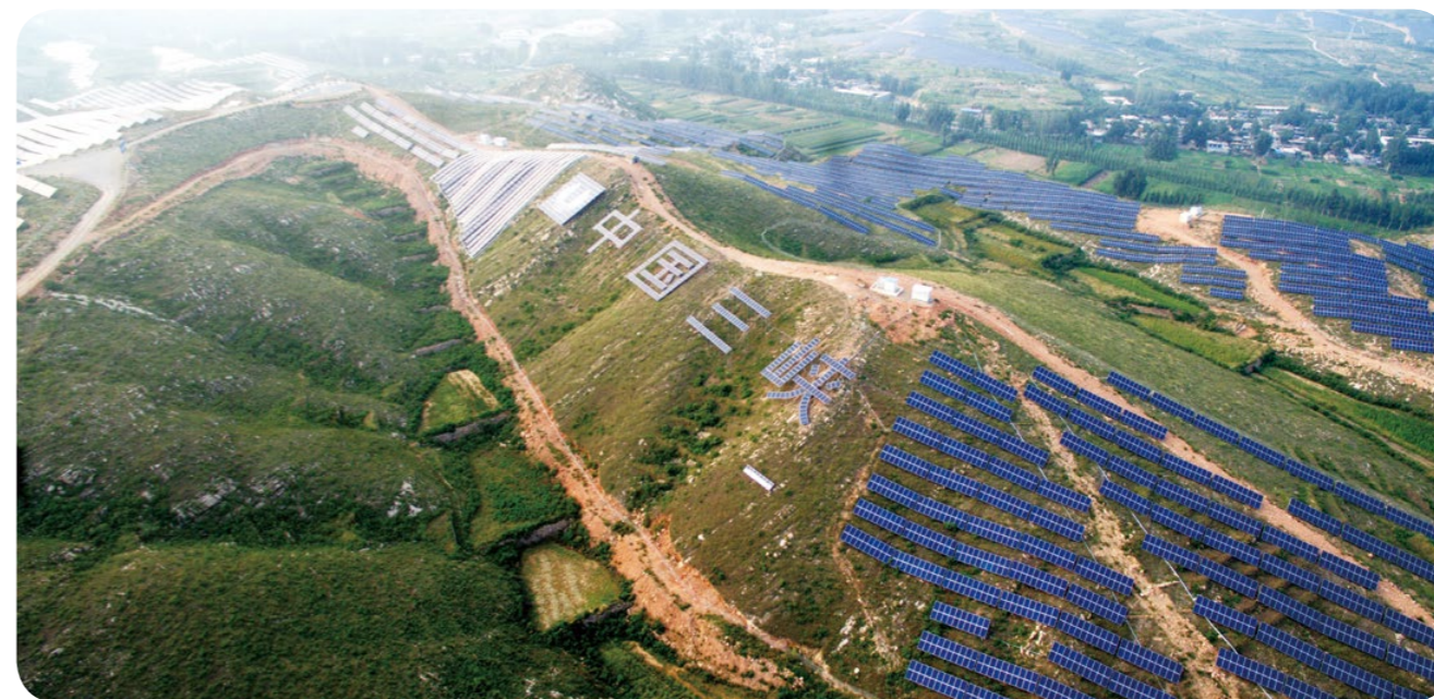
河北曲阳 20 万千瓦光伏项目
