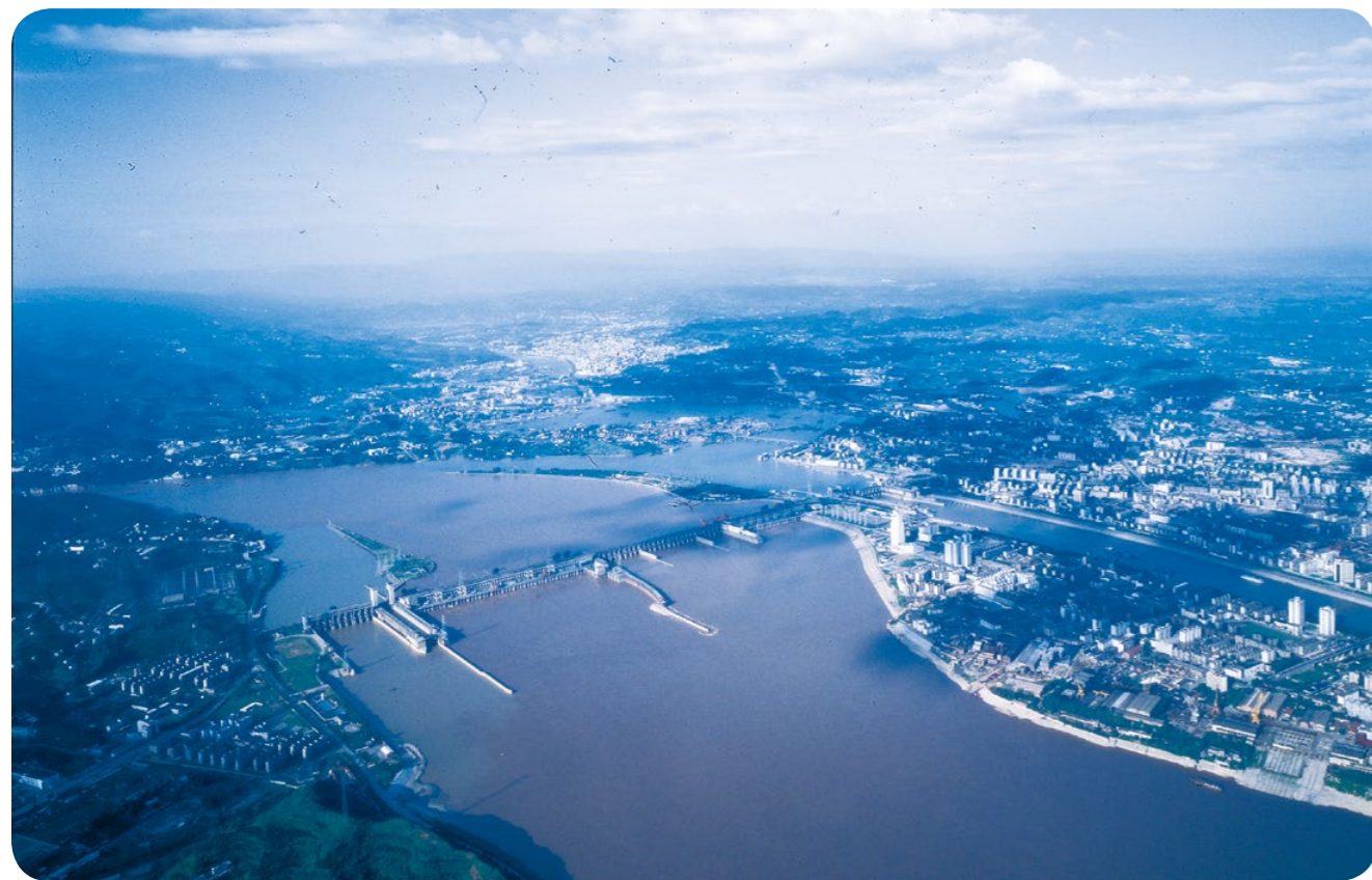
葛洲坝水利枢纽
