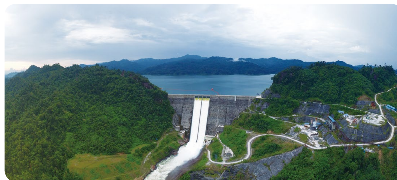
马来西亚沫若水电站
