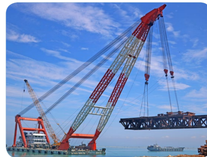
福建兴化湾海上样机试验风场正在施工
