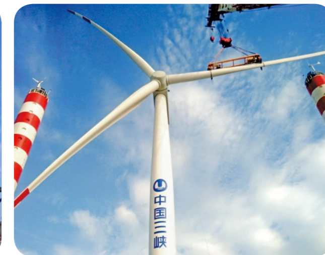
江苏响水海上风电项目风机吊装
