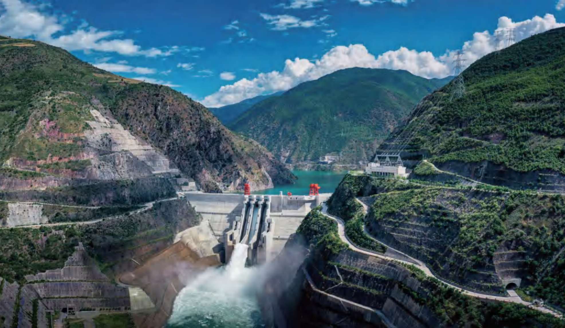
黄登水电站大坝全景 摄影/顾克喜
