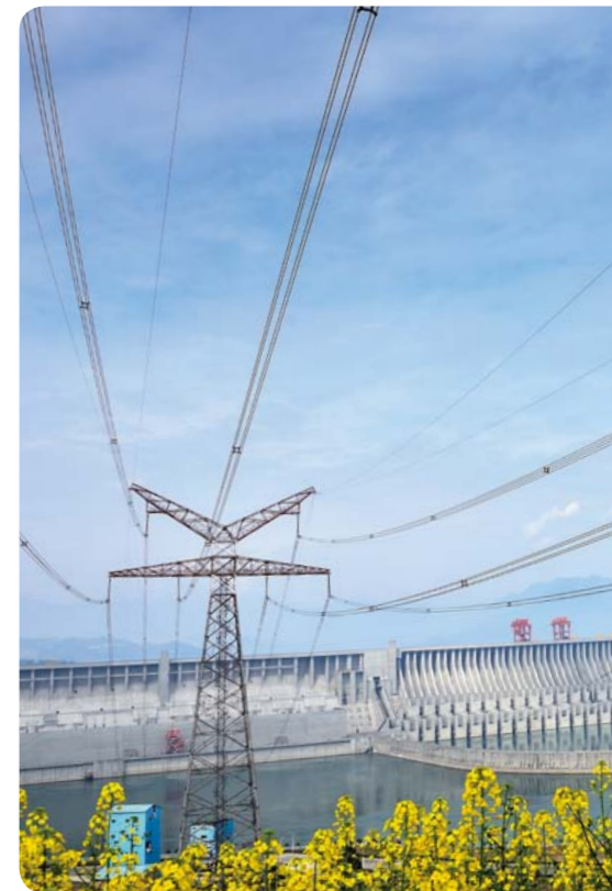
三峡电站电力外送
