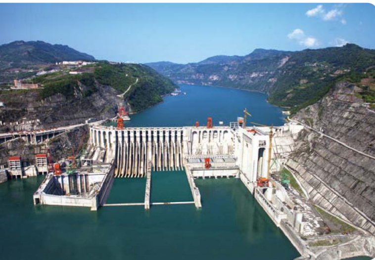
向家坝水电站
