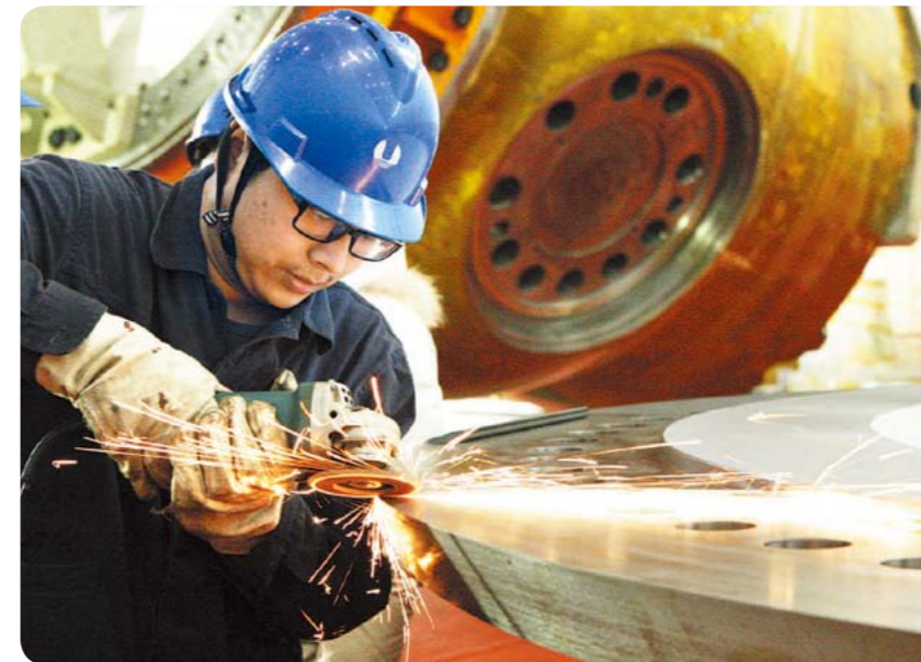
检修人员进行转轮下端盖抛光
