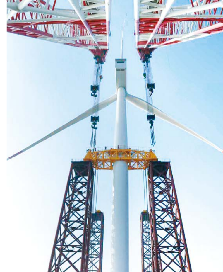
江苏响水 20 万千瓦近海风电项目首台风机成功吊装
