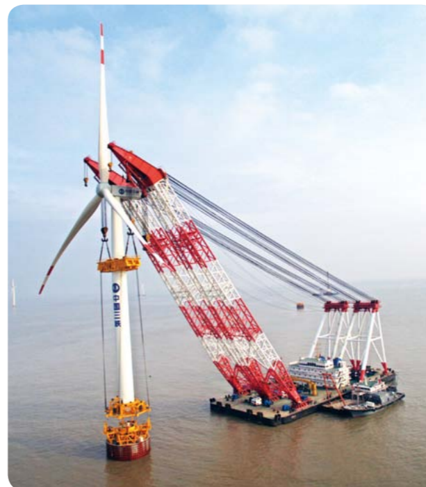
江苏响水 20 万千瓦近海风电项目海上风机吊装
