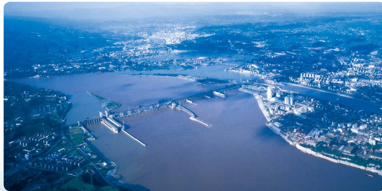
葛洲坝水利枢纽
