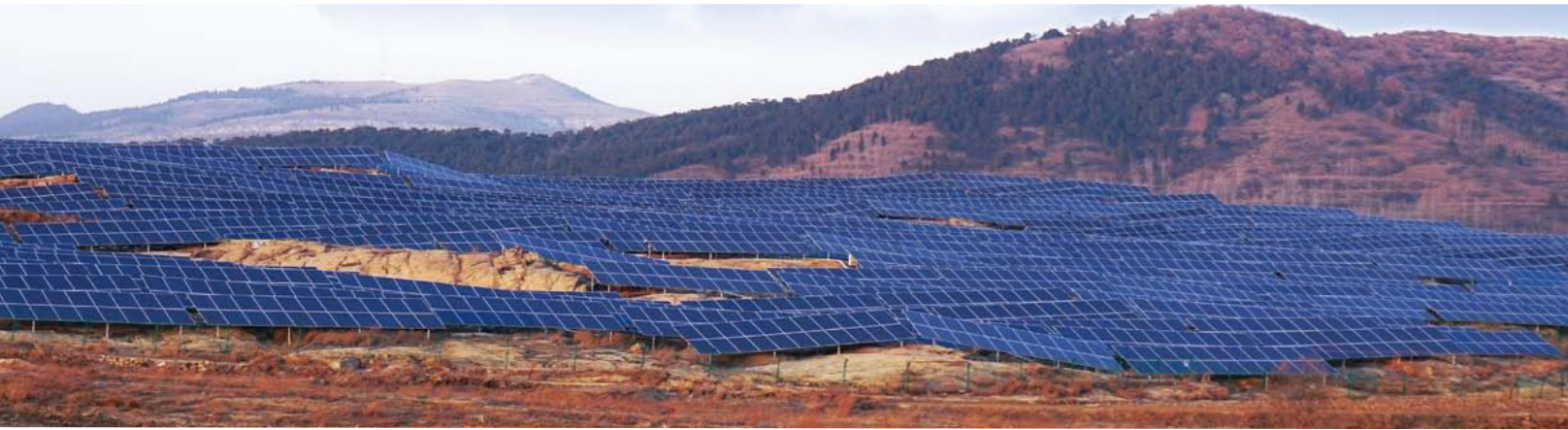
山东新泰 3 万千瓦光伏项目
