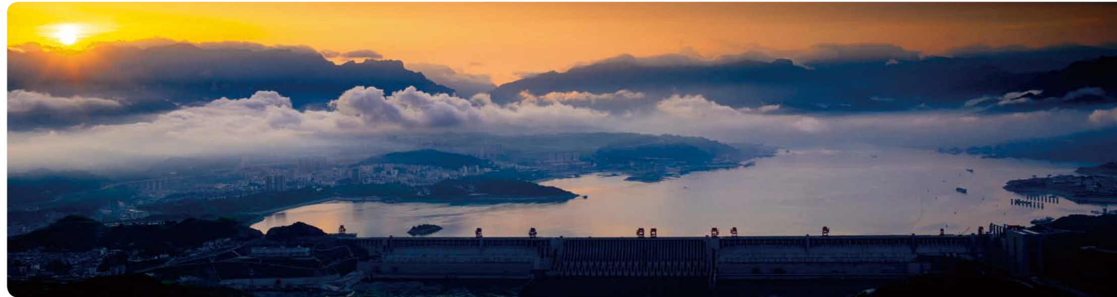
夕阳下的三峡大坝
