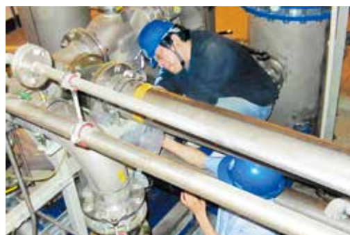
三峡机组定子检修平台第一发明人与检修人员在进行三峡电站纯水装置检查
