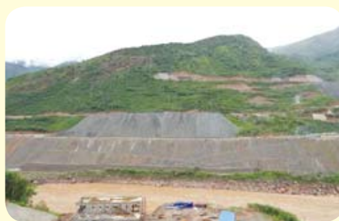
新建村渣场沿江挡护
