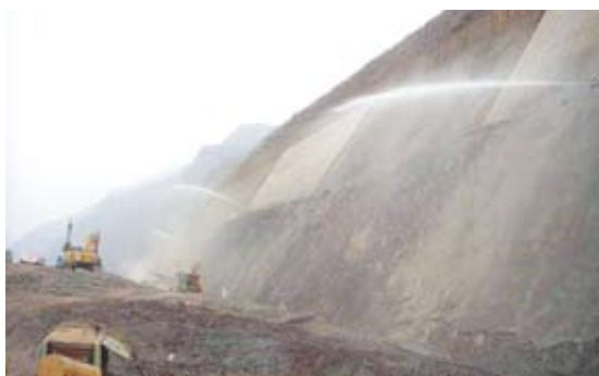
白鹤滩坝址施工区洒水降尘
