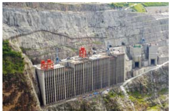
溪洛渡水电站分层取水设施建设
