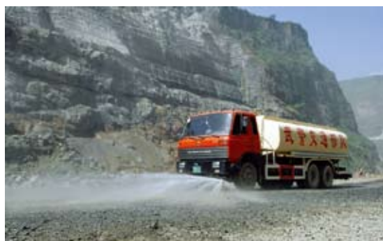
溪洛渡水电站施工区洒水降尘
