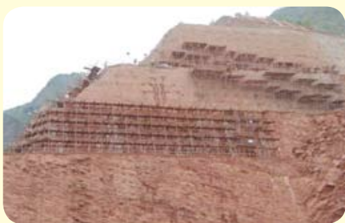
右岸下红岩开挖边坡支护
