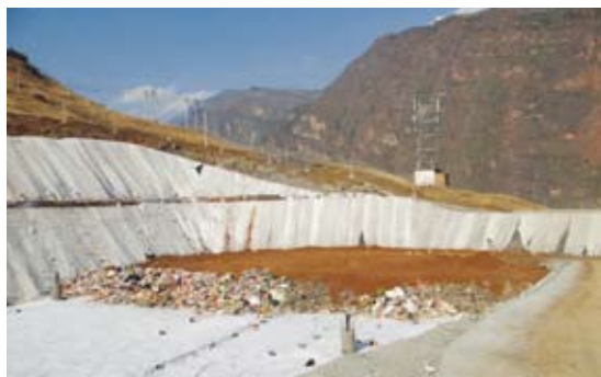
白鹤滩水电站永久垃圾填埋场
