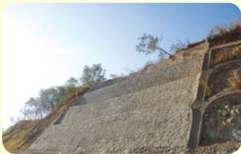
主线公路边坡防护
