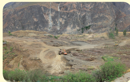
施工期料场表土收集
