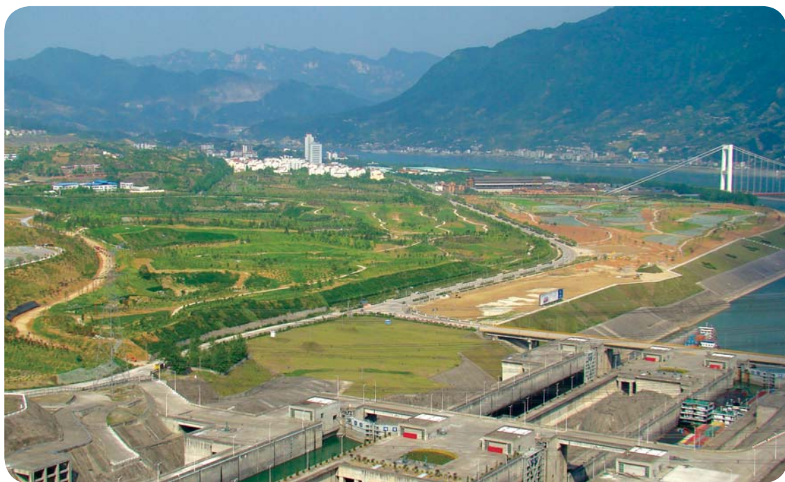
望家坝临时营地生态修复工程
