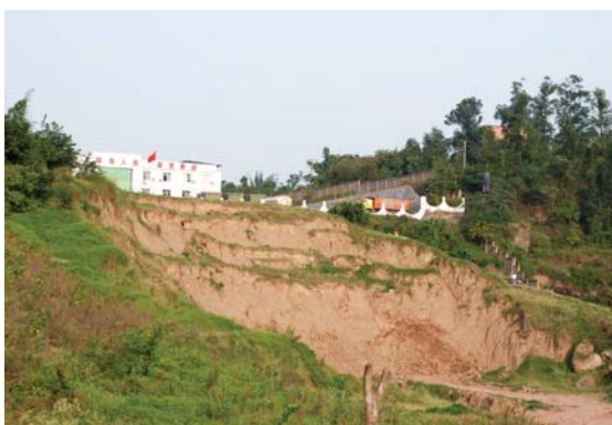
向家坝表土资源大量回采用于施工区绿化和植被恢复
