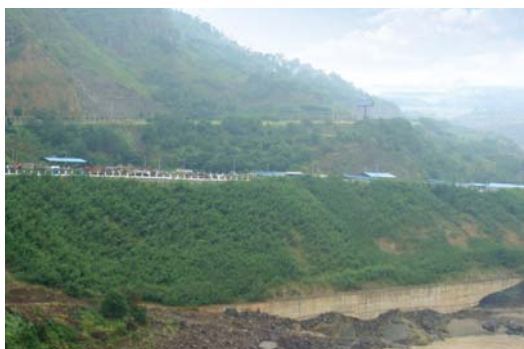
溪洛渡沟渣场边坡人工修复和自然恢复
