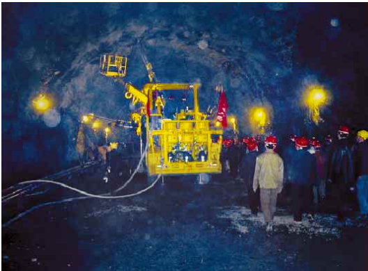
2号公路隧洞施工
