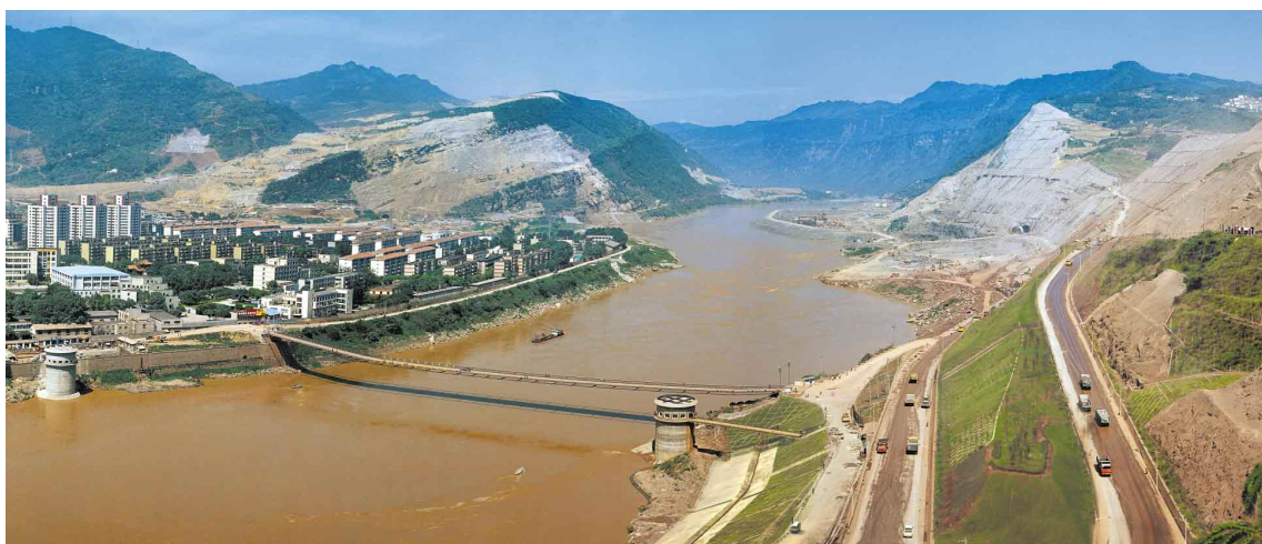
向家坝水电站坝址施工现场
