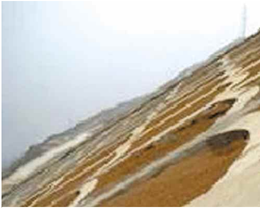
公路边坡网格梁防护
