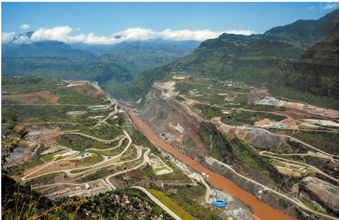
溪洛渡水电站坝址施工现场
