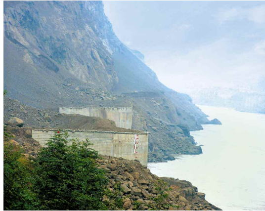
坎肩开挖集渣平台
