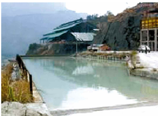
三峡工程施工区生产废水沉淀池
