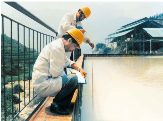
施工废水检查
