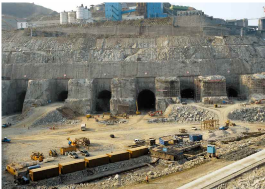
三峡工程右岸地下电站施工现场
