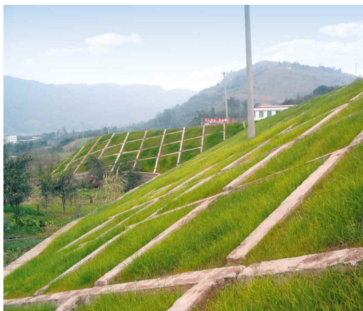
道路固填边坡网格梁植草效果
