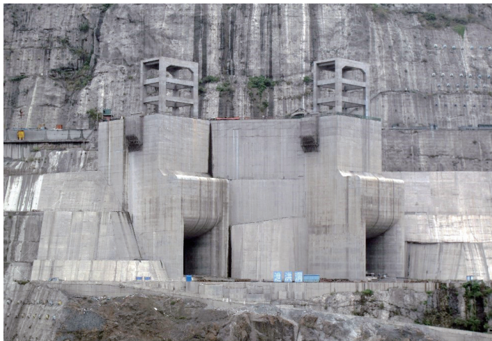
图 2.4-3 右岸泄洪洞进水塔
