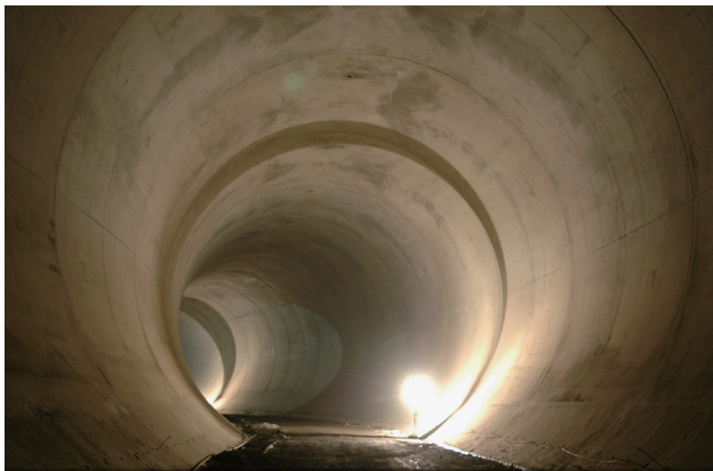
图 2.4-4 泄洪洞有压段
