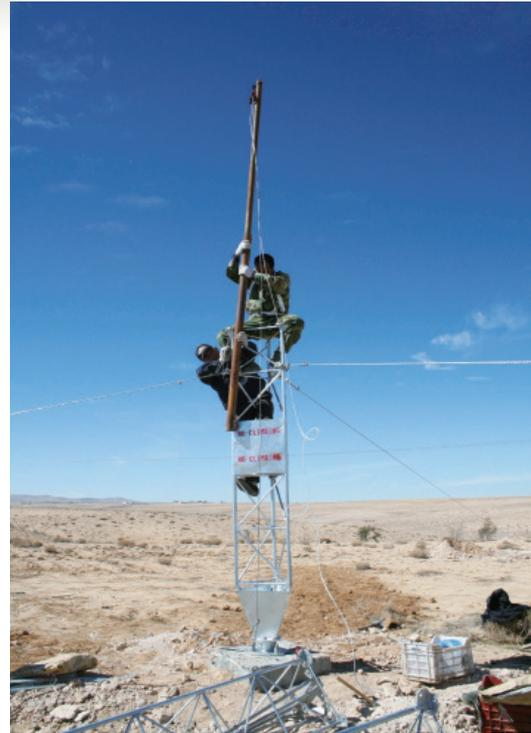
测风塔安装人员在约旦风电项目现场进行测风塔安装
