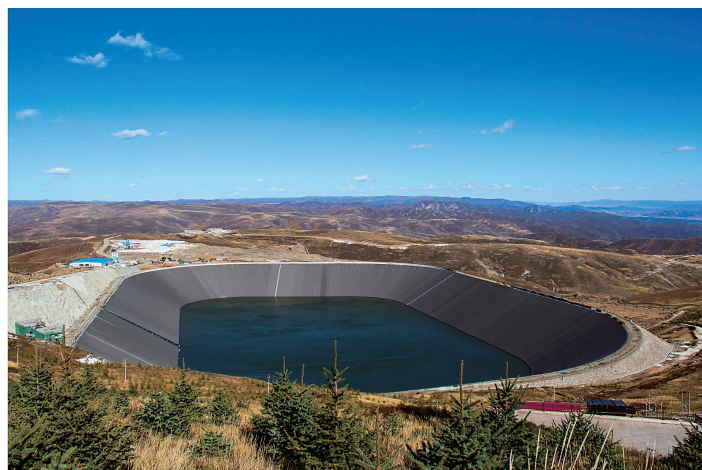
完成初期蓄水
